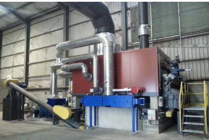
Producimos con paja de cereal el aire caliente necesario para el secado de la alfalfa y los forrajes de la fábrica sustituyendo a un quemador de combustible fósil (fuel-oil y gasoil)
