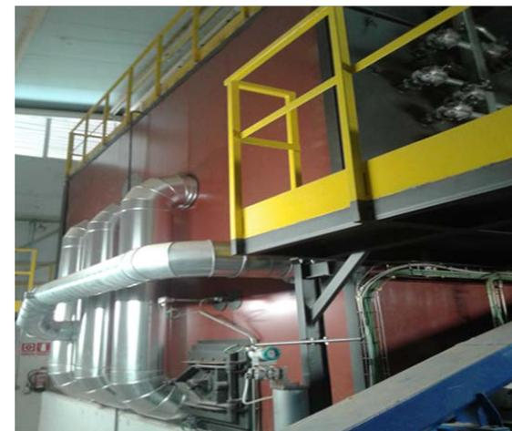
Producimos vapor, para el tratamiento térmico de la leche y otros procesos de fabricación, con paja de cereal que sustituye a una caldera de Gas
